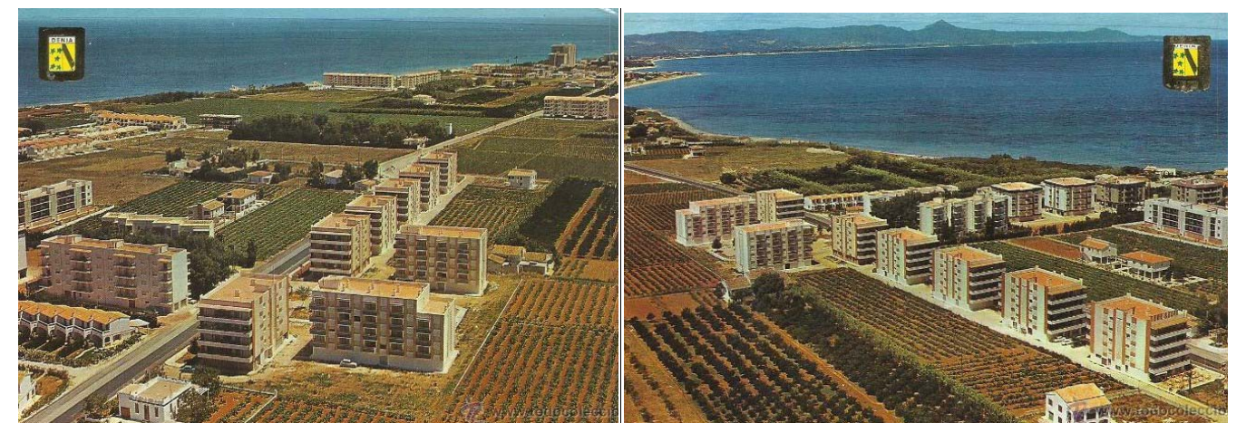
63-64-65-66 Primeras urbanizaciones de les Marines : apartamentos Tetom, Villas Ferrer, en primer plano y apartamentos Nova Dénia.
