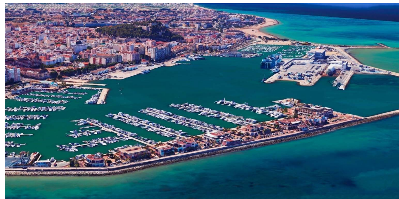
86 El puerto de Dénia en la actualidad. En primer término la Marineta , centro comercial y de servicios; en segundo, la terminal de pasajeros.
