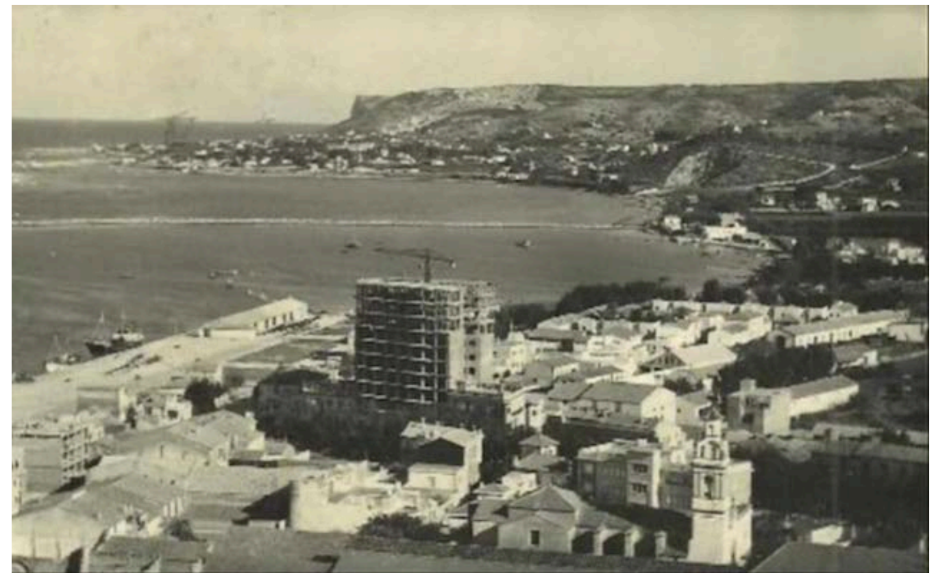
41 Edificio HEVATRON en construcción, ca. 1963. Obsérvese, al fondo, la ocupación en diseminado de les Rotes .
