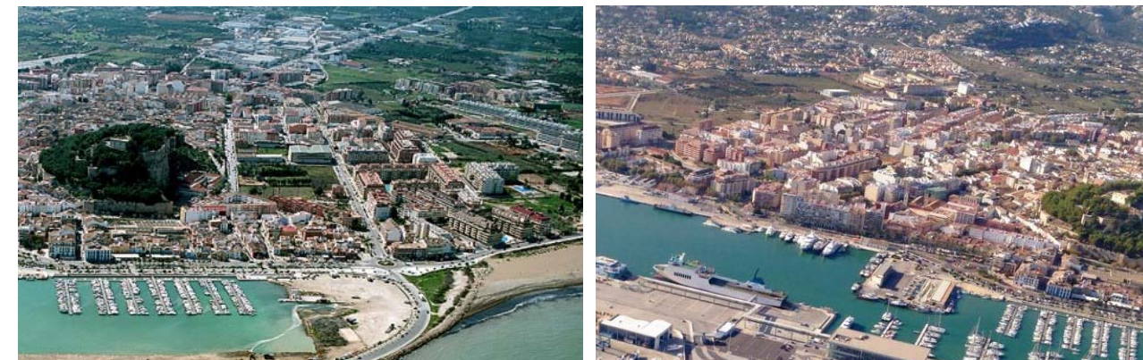
75-76 Vistas de las Coronas norte y sur
