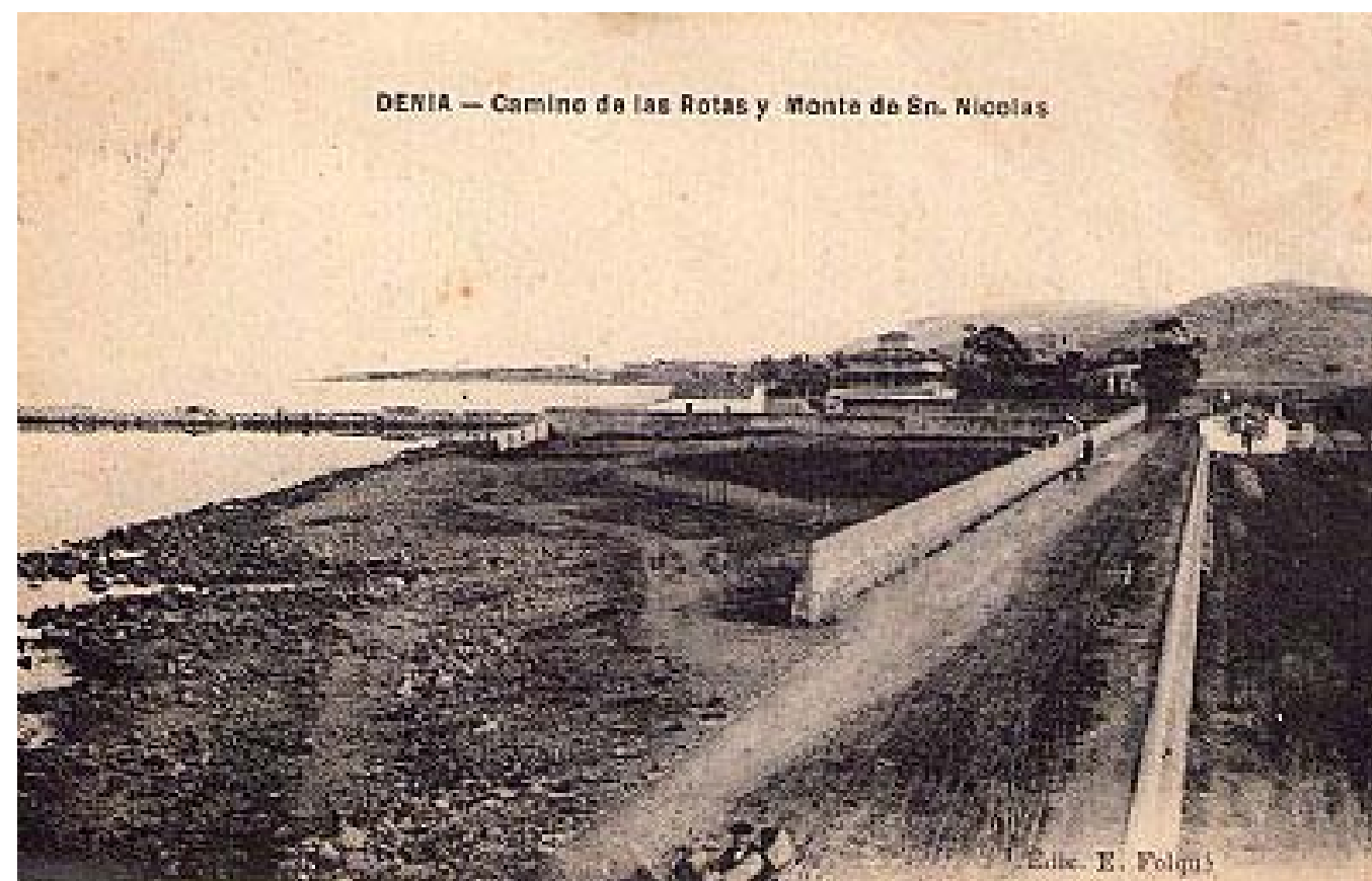
29 La carretera les Rotes (años 30 del siglo XX), delimitada por dos muretes de mampostería.
